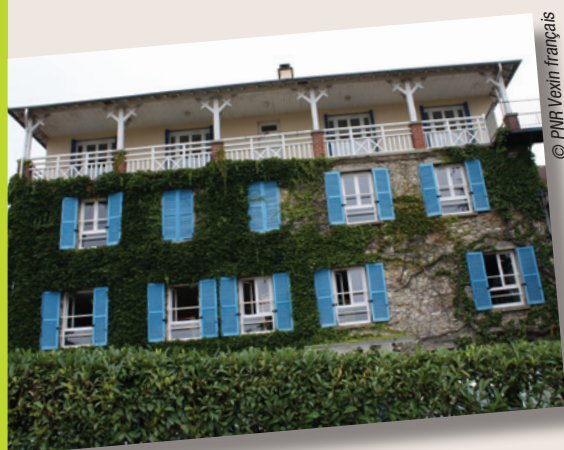
Foyer du Moulin Vert
